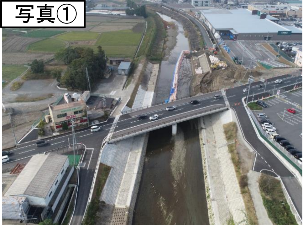
↑令和4年12月19日に橋梁の架替が完成しました。
