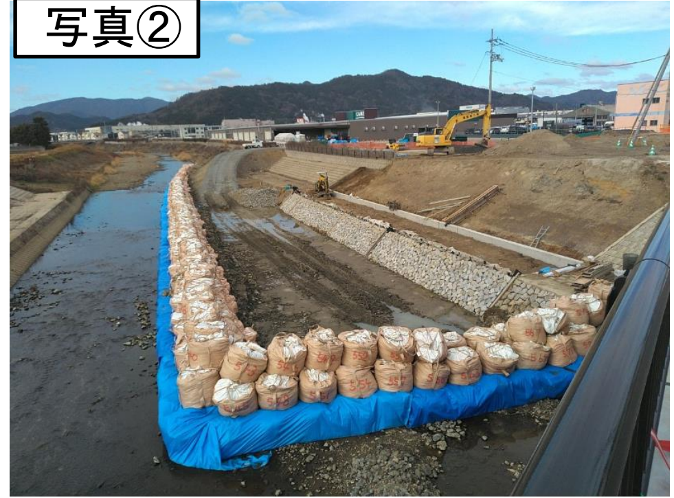
↑護岸工事の施工状況です
