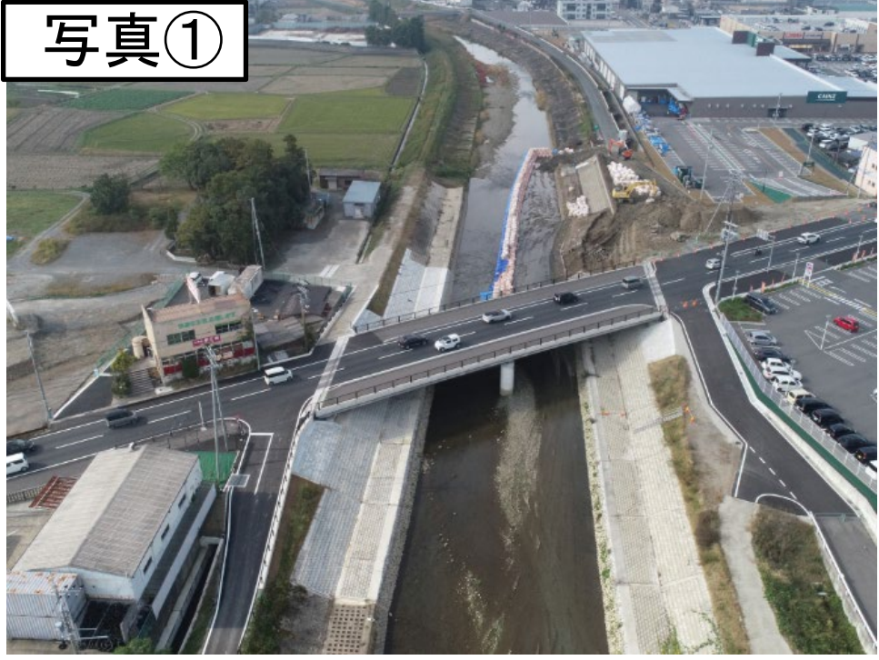
↑令和4年12月19日に新しい若宮橋と国道が完成
