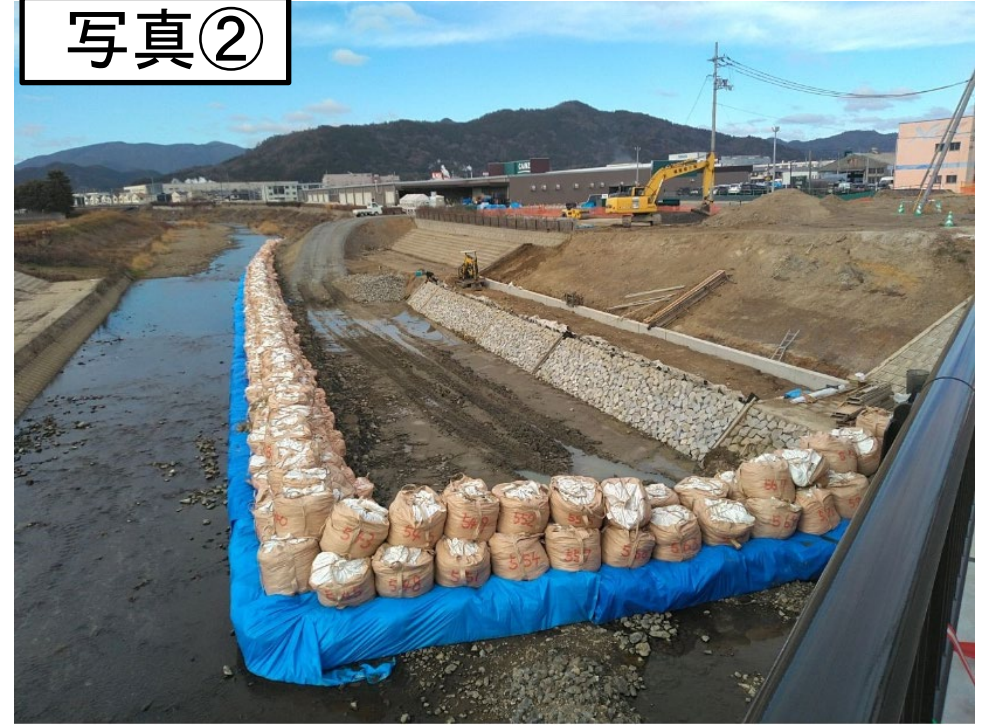
↑新しい若宮橋とあわせ川を広げる護岸工事の状況
