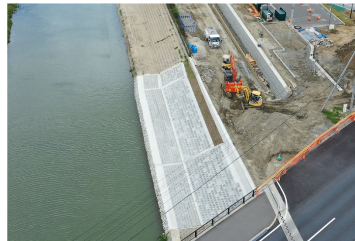
↑新しい若宮橋とあわせ川を広げる護岸工事の状況
