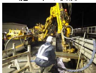
施工中の状況
