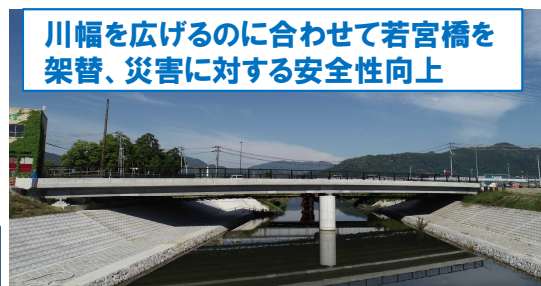
完成後の若宮橋
