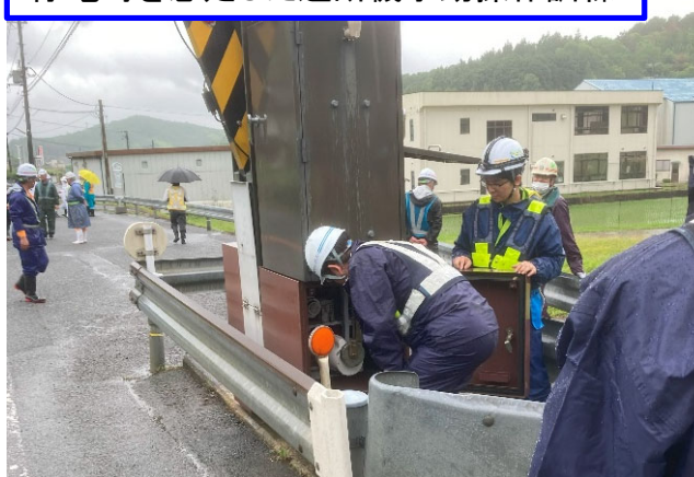
停電時を想定した遮断機手動操作訓練
