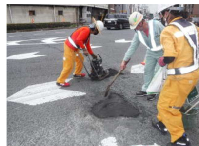
応急的な補修
