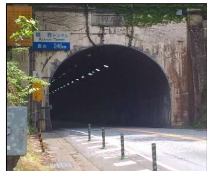
国道9号 かんのん 観音トンネル
