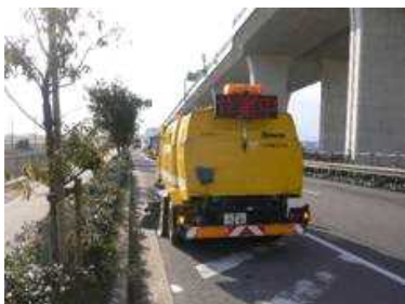
路面清掃作業
