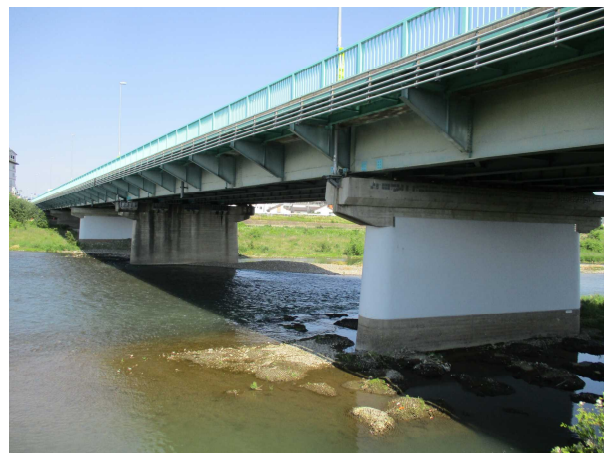
国道9号 西大橋
