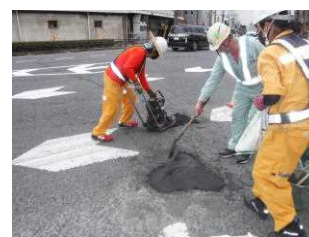
応急的な補修
