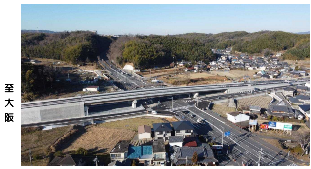
■ 乾谷地区の整備状況 (令和5年1月11日撮影)
