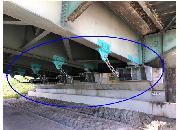
○ 上部工：落橋防止、支承補強
