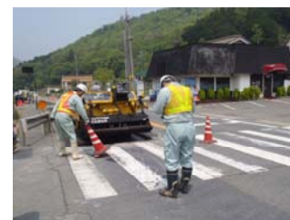
応急的な補修
