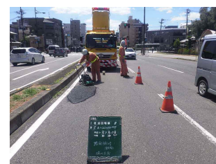
応急的な補修
