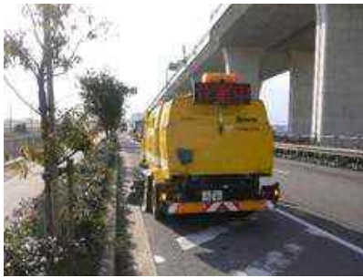
路面清掃作業
