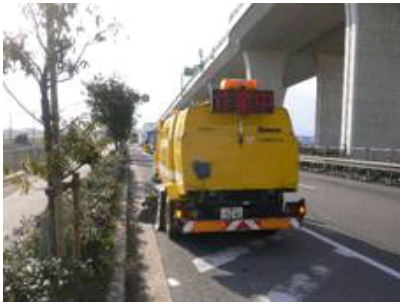
路面清掃作業
