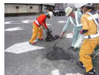
応急的な補修
