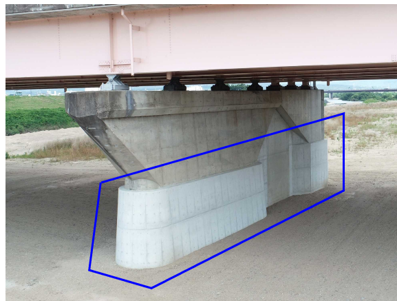
□ 下部工：コンクリート巻立て工
