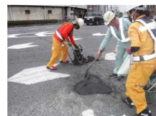
応急的な補修
