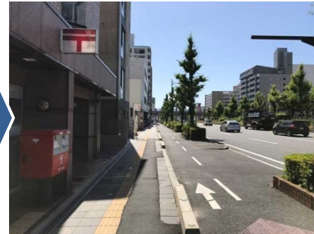
■ 整備後 (南側歩道)
