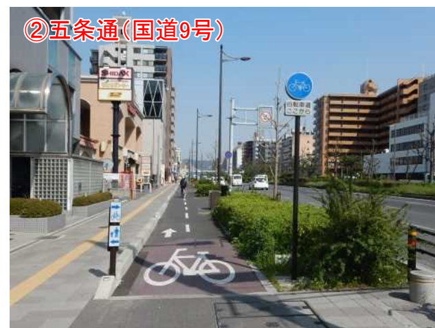
自転車道(標識設置。幅広歩道を縁石で分離。)
