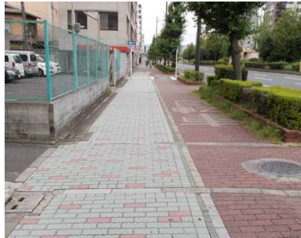
■ 整備前 (南側歩道)
