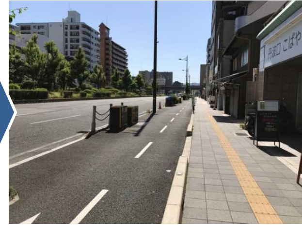
■ 整備後 (北側歩道)
