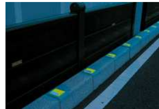
反射材の例（出典：積水樹脂(株)HP）
