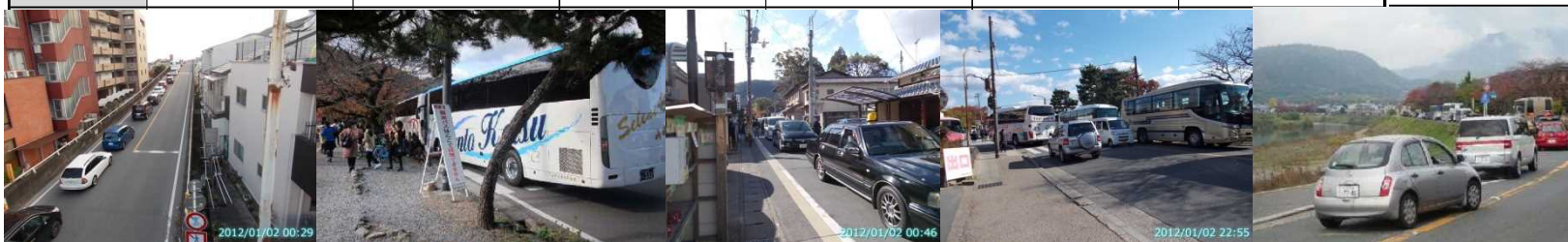
清滝道高架道路
