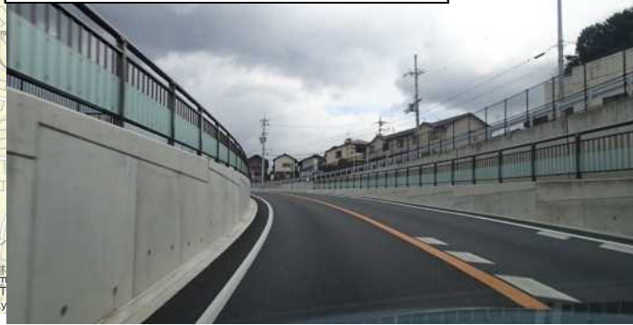
■ 整備後の状況(アンダーパス部)
