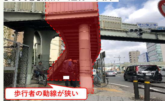
【写真③】階段が通行の支障
