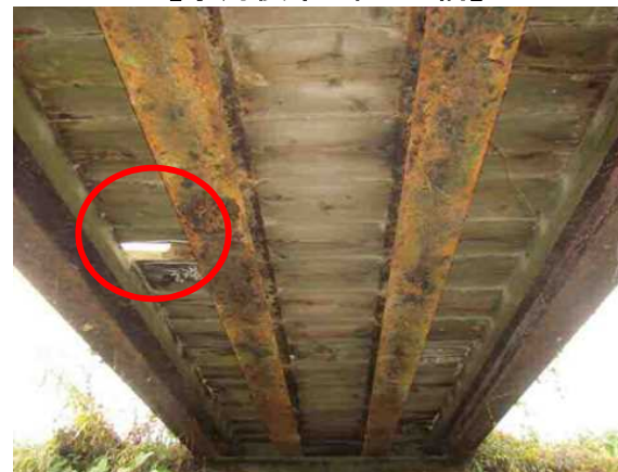
【京丹後市 中ノ堂橋】
