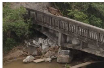
写真-2 平田・小柳線 田中橋
