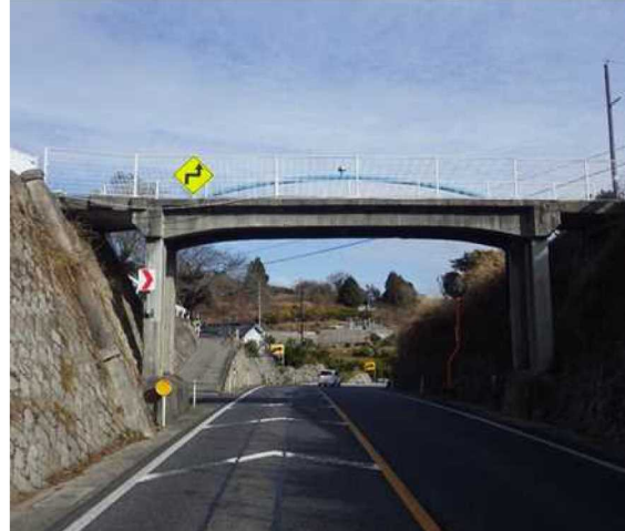
地方管理の跨道橋(未対策)
