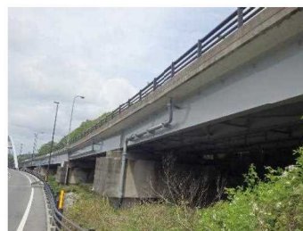
写真-4 阿蘇口大橋 (国道57号)
