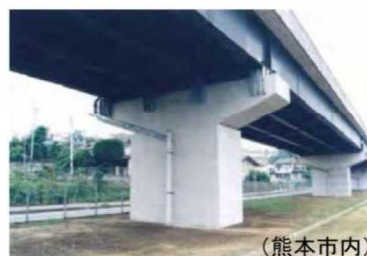
写真-3 国道3号 跨線部 (熊本市内)
