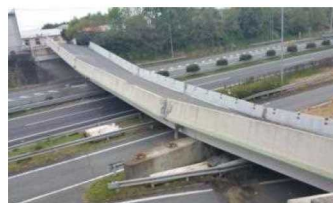
写真-1 県道小川嘉島線 府領第一橋
