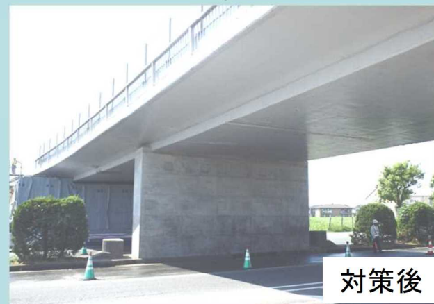
耐震補強の施工例
