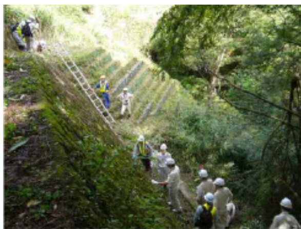
道路防災ドクターによる現地診断
