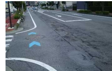
占用工事が起因する路面損傷
