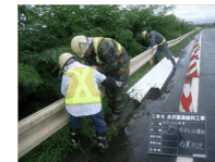
<防護柵の取替>
