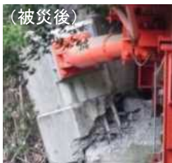
制震ダンパー取付部の損傷
