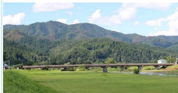
<万石橋の状況>
