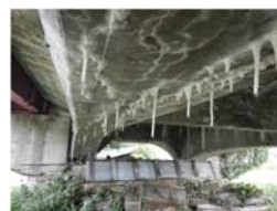
主桁のひびわれ
