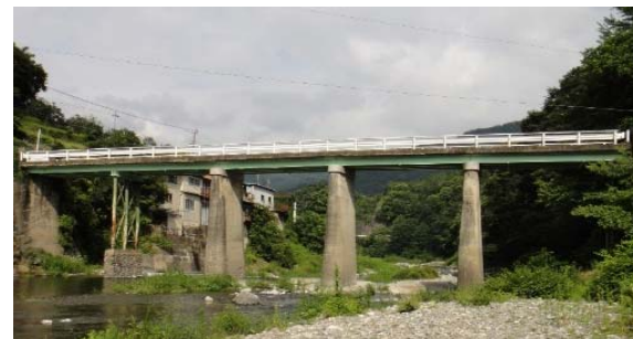
<御鉾橋の状況>
