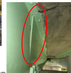
主桁の変形
