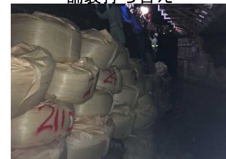
大型土のう設置
