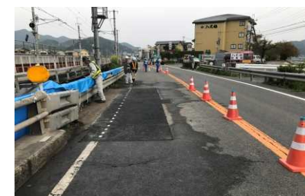
舗装打ち替え
