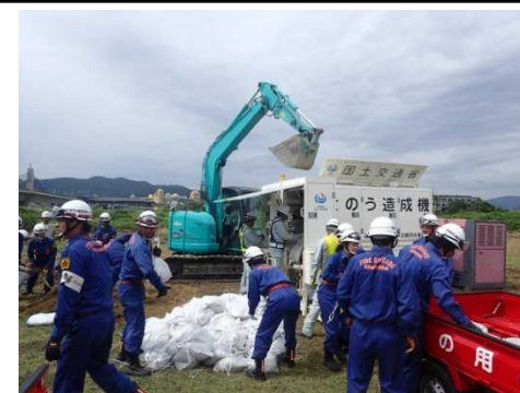
土のう作成状況
