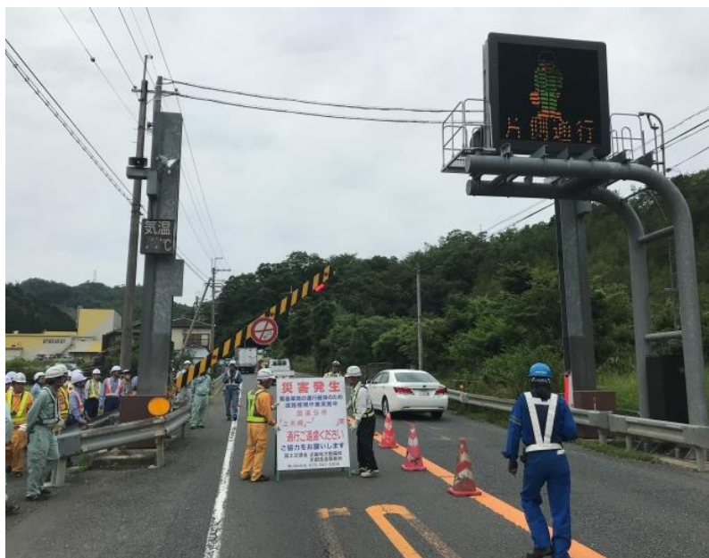
遮断機の訓練状況
