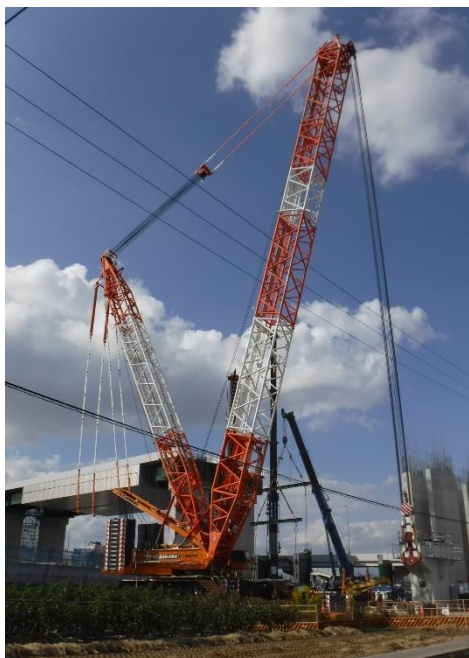
国内最大級1250t吊 クレーン
