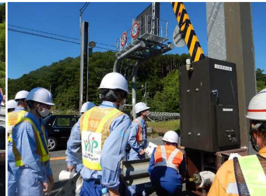
遮断機 手動操作訓練(停電時)
