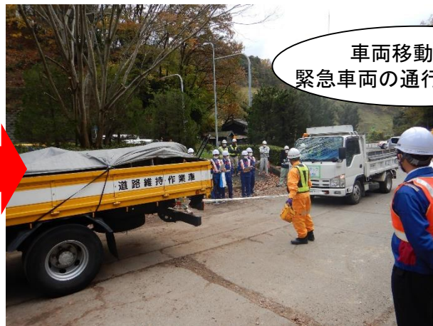
標識車による、牽引ロープを用いた トラックの移動
