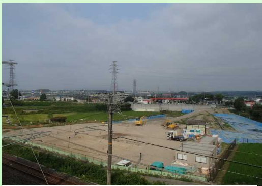
道路振替作業状況(平成29年7月中旬)
