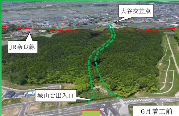
進捗状況写真
