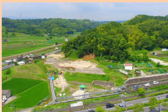
掘削前の準備作業状況(平成29年06月末ごろ)
