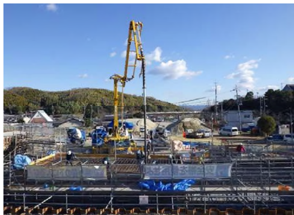
カルバート工(乾谷・三本木線) コンクリート打設状況
