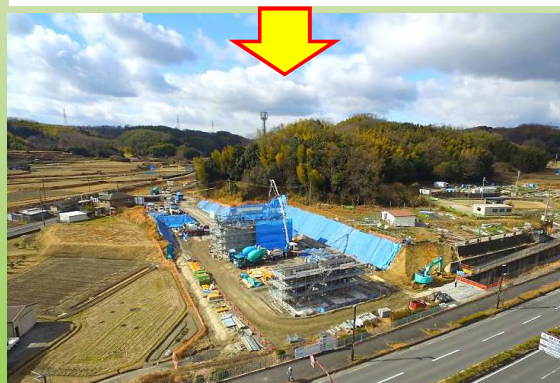
本体構造物作業状況(平成30年01月25日)
