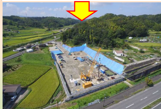
場所打杭作業状況(平成29年09月末ごろ)
