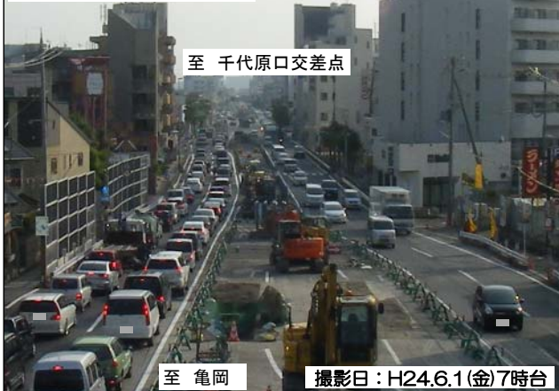
開通前の交通状況
