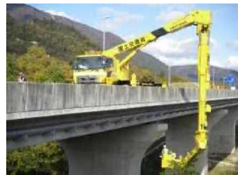
橋梁点検車による点検
