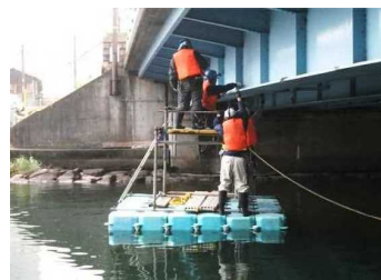
船(フロート)による点検
