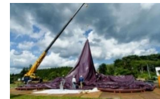
設置中の様子
