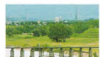
第二京阪道路から流れ橋をのぞむ(八幡市木津川)
