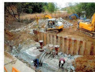
水道管補強に伴うバルブの撤去工事
