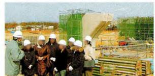
背後の橋脚は、コンクリートが固まったので型枠を外しているところです。
