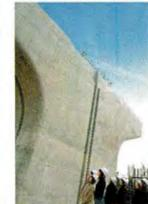
この上に橋桁が架かり、自動車専用道路となります。横にある溝の中に配水管が納まるので、スッキリした表情です。
