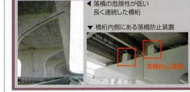
3 橋桁が落ちない仕組みを採用
