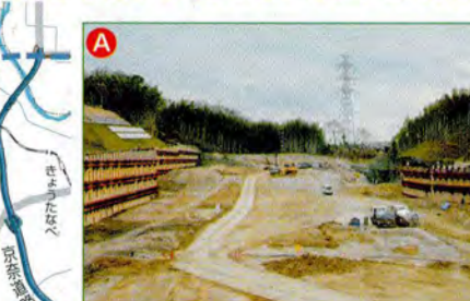
枚方東ICの南側、掘削区間の掘り下げが進んでいます。両側の擁壁が姿を現しました
