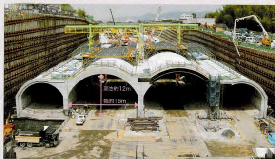
掘削幅約60m、最大の深さは約28mに及び、国守・打上区で約60万㎡の土を外に出します。このトンネル構造物が完成すると順次埋め戻しをしていきます。
