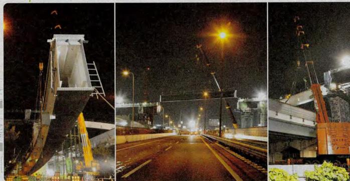
**静** かな上空に大型クレーンによって吊り上げられた巨大な橋桁の架設を行います。現地で組み立てた橋桁を大型搬送車で架設地点へ移動。全国に約20台しかない大型クレーンを使って橋桁を吊り上げ、据付け固定。その後、ボルトにより連結します。次に横桁を架設。横桁は、橋桁にかかる荷重を橋全体に分散させる目的で設置するもので、橋桁どうしを接合し補強します。そして、橋桁の上に鋼製のパネルを設置します。今後、この鋼製のパネルにコンクリートを打ち、鋼とコンクリートを一体化した合成床版を構築します。
