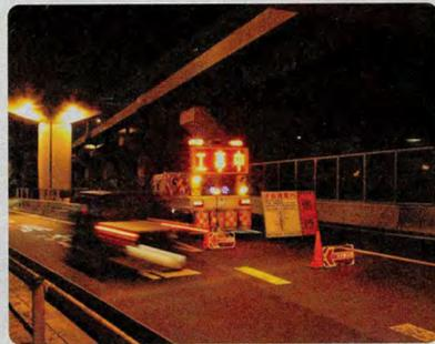
**門** 真JCTの橋梁架設は、交通量の多い近畿自動車道をまたいで行う必要があるため、交通への影響に配慮。橋梁架設工事にあたって、渋滞を起こさないよう交通量の少ない時間帯を選び、3夜間連続して夜22時から翌朝6時までの通行止めを実施しました。あわせて、中央環状線の一部規制など、ドライバーの安全性を考慮して架設工事を進めました。
