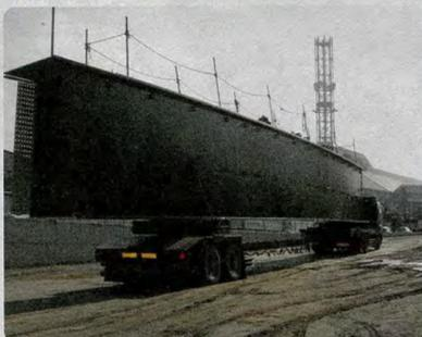
**橋** 梁に架設する鋼材は巨大なため、分割しなければ運べません。工場で作られた各部品を分けて、大型トレーラーで現場へ運搬します。これらの部材は、現場近くの仮設ヤードで完成形または一部分の形に連結して組み立てを行います。架設に不具合がないか外観や採寸など入念に確認します。
