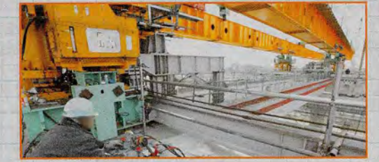
橋脚の間に配置した後、横にスライドさせ橋桁を架設位置まで移動します
