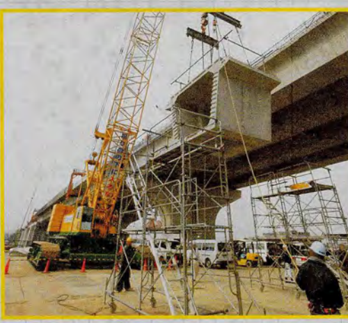
工場で作られたパーツをクレーンで橋の上にあげていきます
