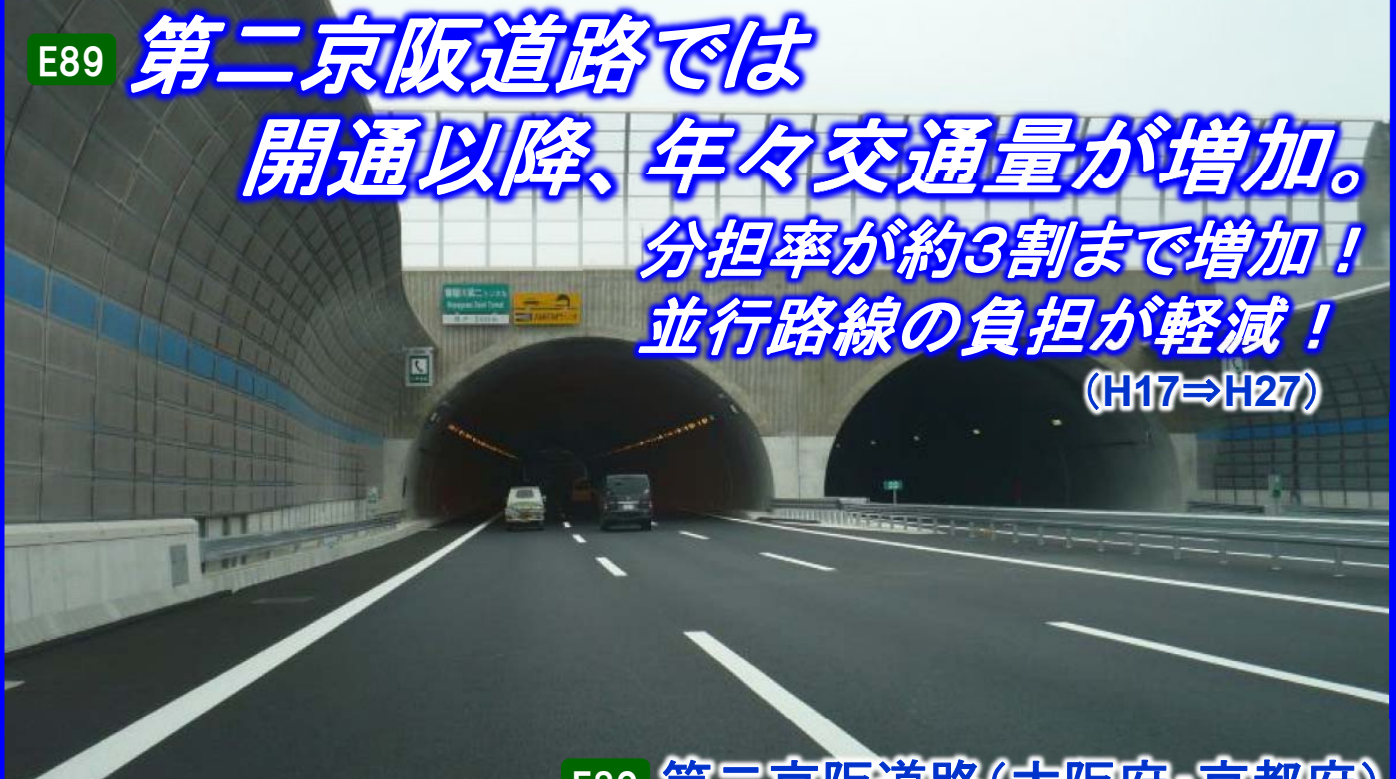
写真：E89第二京阪道路（寝屋川第二トンネル）
