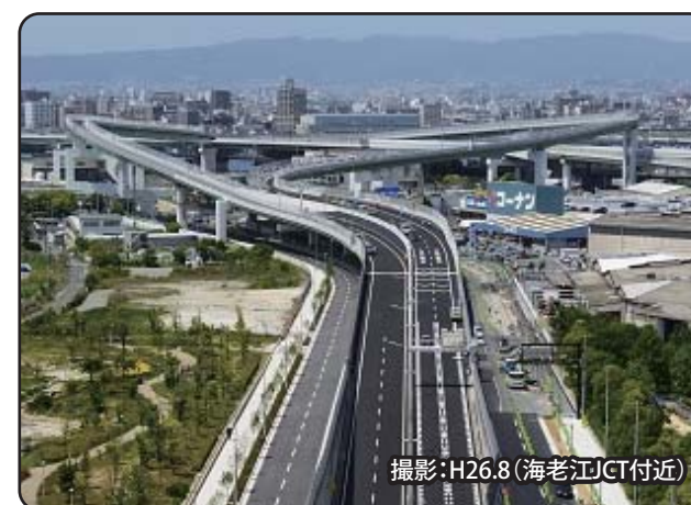
阪神高速 淀川左岸線 Ⅰ期
