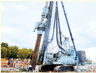
▲杭の打設工事
