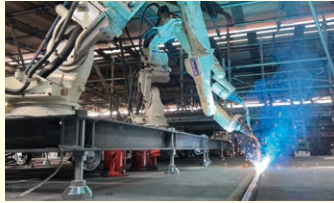
▲溶接ロボットによる作業
