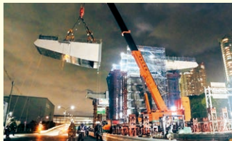
▲梁の組み立て工事
