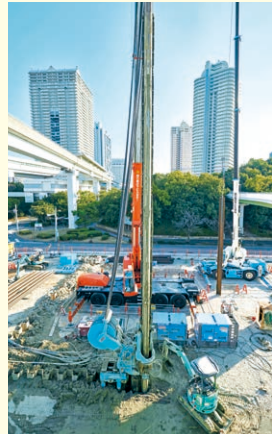
▲六甲ライナー付近での工事
