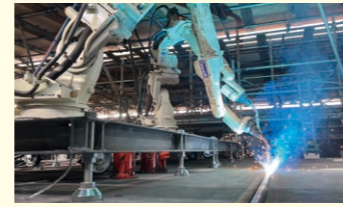
▲溶接ロボットによる作業
