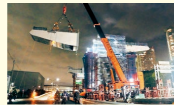
▲梁の組み立て工事
