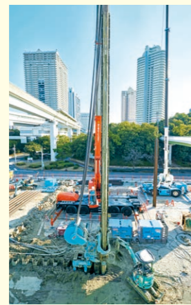
▲六甲ライナー付近での工事
