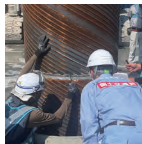
鋼管杭の継ぎ目の溶接を確認中
