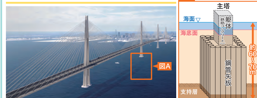
図A 主塔基礎イメージ図
