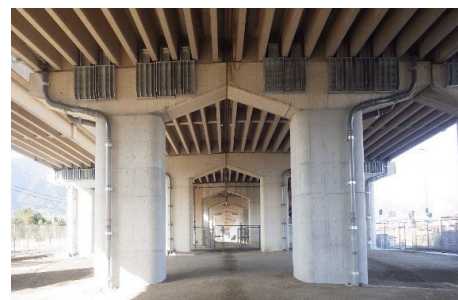
橋梁 耐震補強後
