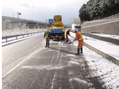
凍結防止剤散布状況
