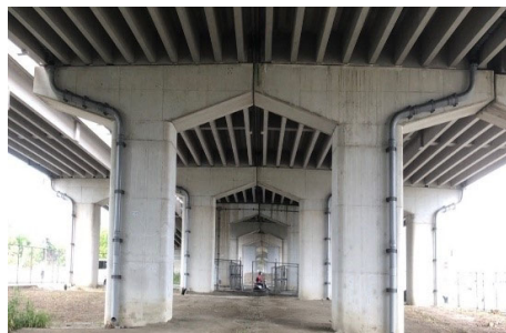
橋梁 耐震補強前
