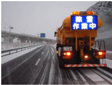
凍結防止剤散布状況
