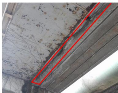
縦目地部の遊離石灰(漏水)
