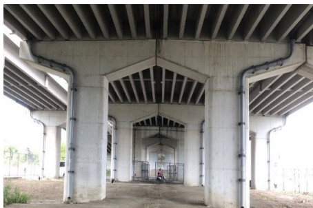
橋梁 耐震補強前
