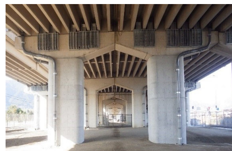
橋梁 耐震補強後
